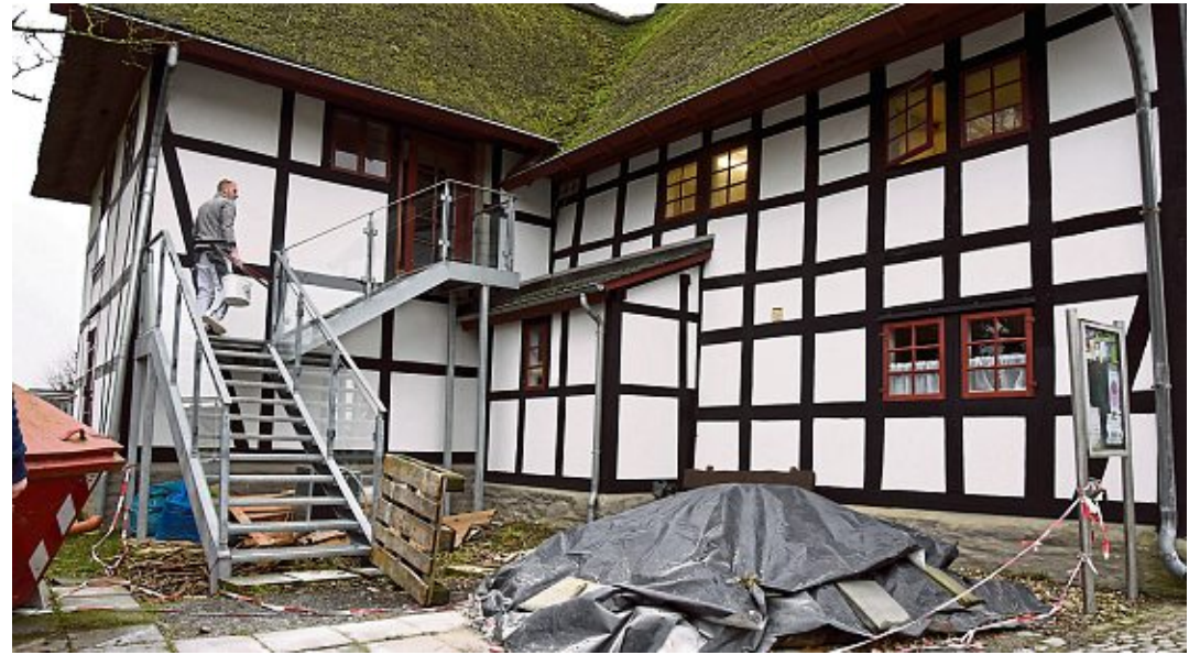
Ein neuer Eingang von der Parkplatzseite steht, drinnen wird mit Hochdruck gearbeitet. Foto: Dierke
